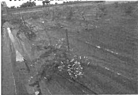
写真8 支柱を設置した様子
